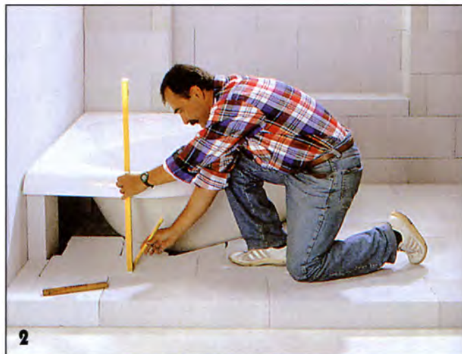
2 Газобетонными блоками можно обложить и ванну. Прежде всего необходимо обозначить линию кладки.
