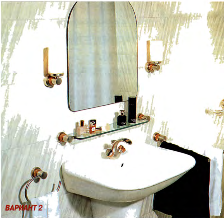
Участки стен в ванной, до которых могут долететь брызги, есть смысл облицевать плёнкой ПВХ, имитирующей керамическую плитку.
