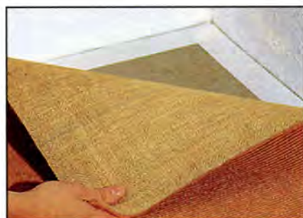
Фиксирование коврового покрытия двусторонней самоклеящейся лентой.
