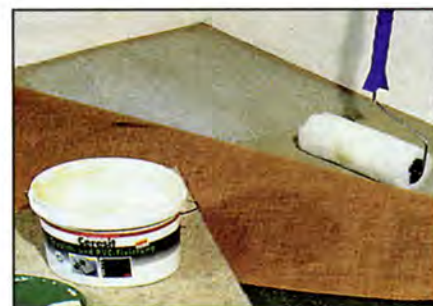
При укладке ковровина сначала отворачивают одну сторону покрытия и наносят на основу фиксирующий состав. Вернув сложенную сторону на место, прижимают её к основе. Затем таким же способом закрепляют и другую сторону покрытия.
