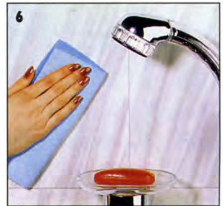
Облицовка из плёнки ПВХ достаточно водо- и износостойка и не требует специального ухода.
