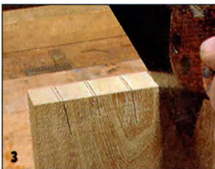
3 По разметке делают пропилы до линии заплечиков.
