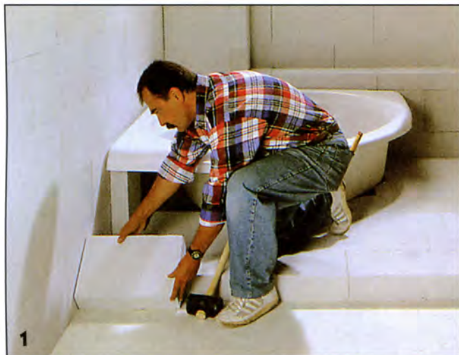
1 Окончательно установив ванну, около неё на подготовленной основе формируют подиум из газобетонных блоков.
