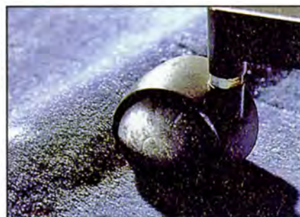
Проверка качества укладки покрытия. Если ролики стула при его перемещении образуют на ковровом покрытии волны, значит оно уложено неправильно.
