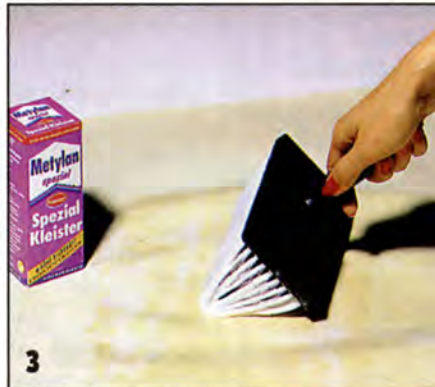
Приклеить полотнища к стенам можно на густом обойном клейстере, который наносят на тыльную сторону полотнищ,...
