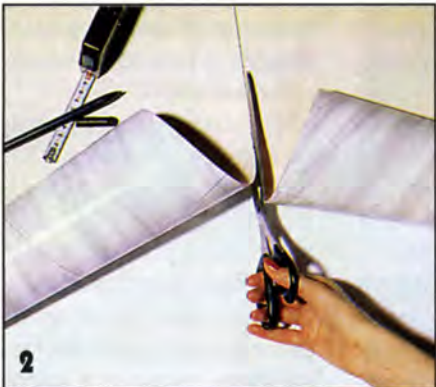
Плёнку раскраивают ножницами на полотнища.
