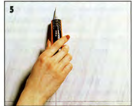
На стыки между уже приклеенными и просохшими полотнищами наносят клей для холодной сварки ПВХ.
