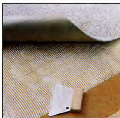
ДСП – в принципе хорошая основа под ковровое покрытие, однако до нанесения клея её нужно обработать грунтом глубокой пропитки.
