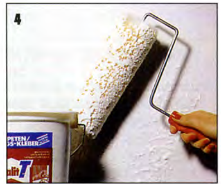
...или специальным клеем, которым промазывают стены.
